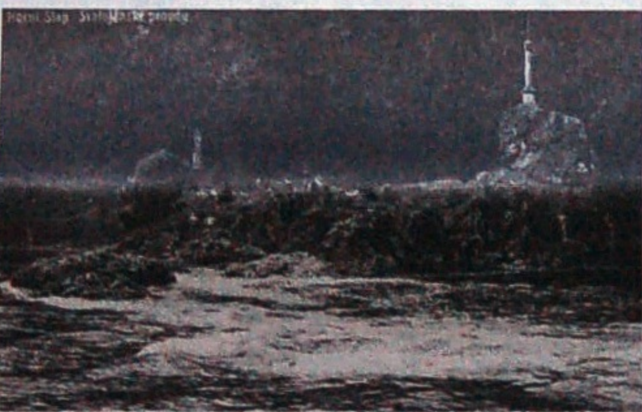
SVATOJÁNSKÉ PROUDY. Kamenný Ferdinandův sloup i socha svatého Jana jsou dnes umístěny pod hrází Slapské přehrady.
